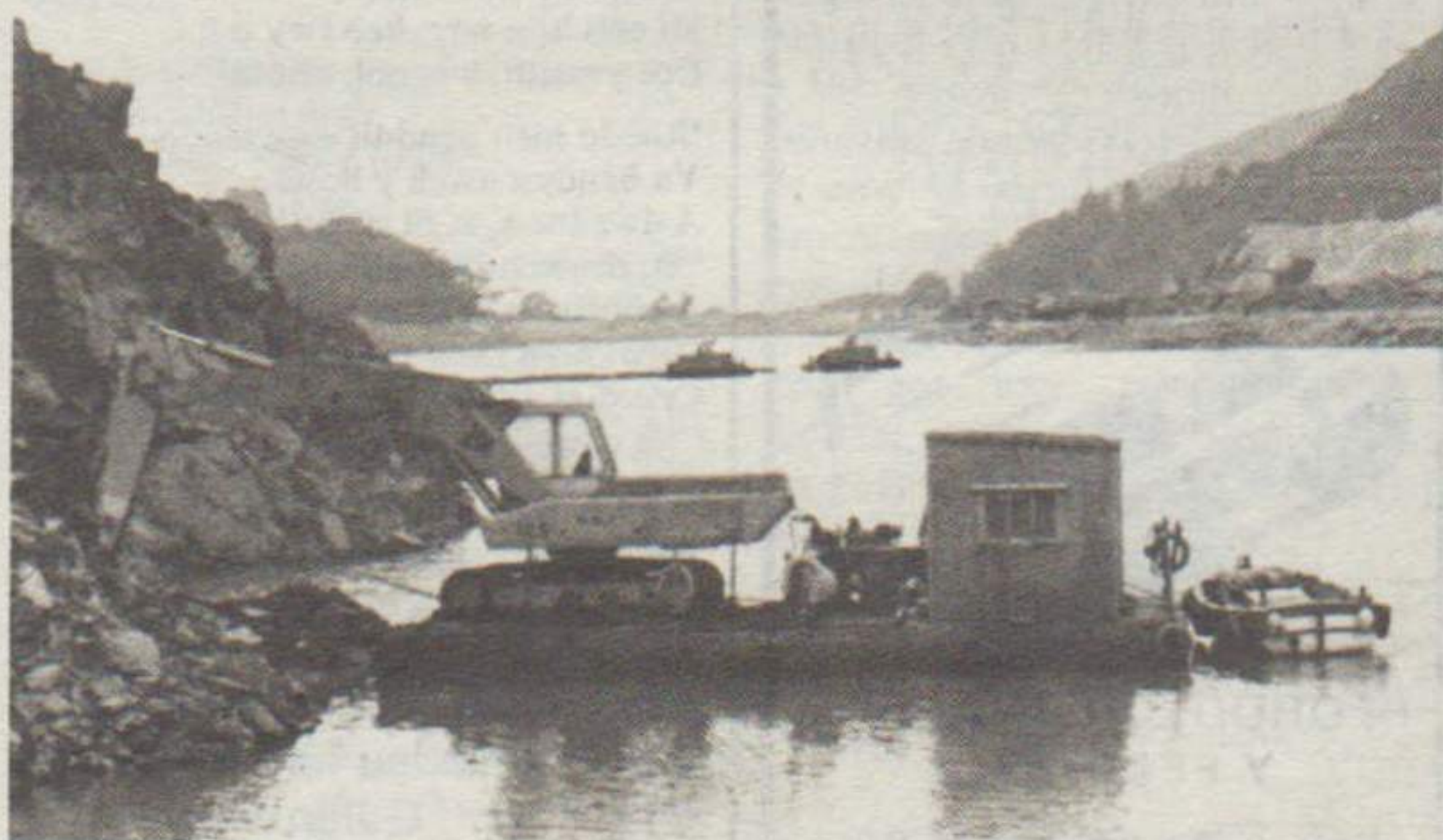
JCB ar lwyfan bychan ar y dŵr. Ei waith yw crafu'r rwbef a'i lwytho i fad sy'n ei gario i'r lan. Dyma'r un ffordd o glirio'r ochrau serth. Mae gweithio o'r dŵr yn ffordd o ofalu nad yw'r glannau'n cael eu hagru'n ormodol gan y peiriannau trwm. Yn y cefndir yng nghanol y llyn gwelir dau o'r peiriannau sugno.
